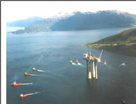
Plateforme 'Troll' – Mer du Nord.
